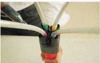
14、将电缆穿进热缩套管，并用电吹风热缩
