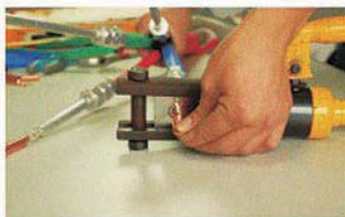
20、用压线钳将接头压紧，压接顺序是从端子头部向导体连接端顺序压接
