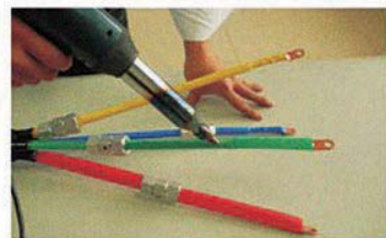
21、将电缆线芯穿入热缩套管，并用电吹风热缩
