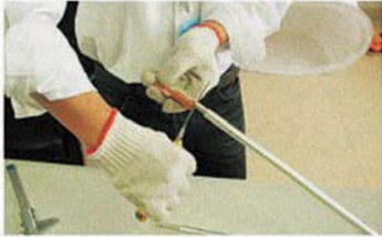
10、根据端子的插入深度，确定云母绝缘剥除长度
