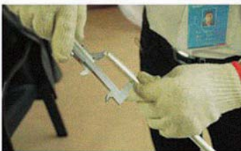
7、端头铝管剥除长度为70~80mm
