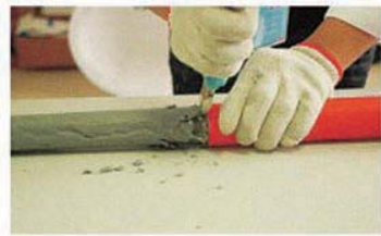
3、用斜口钳剥除耐火层
