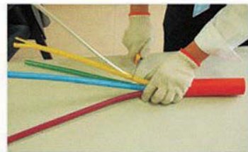
6、根据安装需要适里剥除分色隔离套
